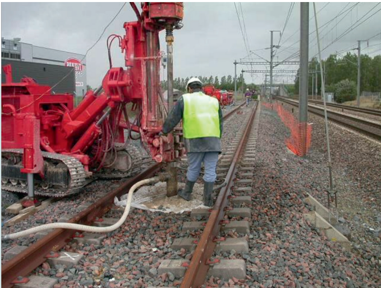
▼ Renforcement d'une plateforme ferroviaire grâce à la technique « Soil Mixing ». ▲
