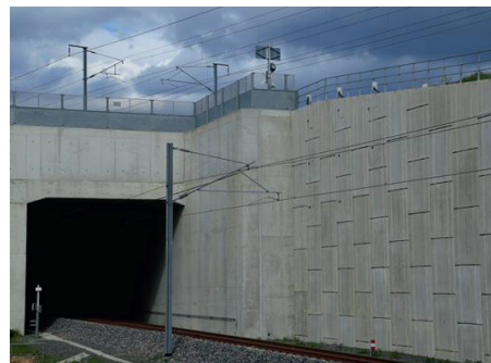
▲ Soutènement sur la LGV SEA 2
