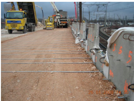
▲ Soutènement en bordure de voie
