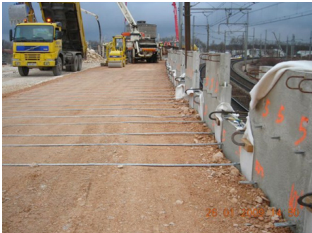
▲ Soutènement en bordure de voie
