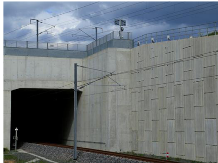
▲ Soutènement sur la LGV SEA 2
