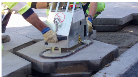
▲ Essai de démontage-remontage sur le démonstrateur de CUD de Nantes métropole
