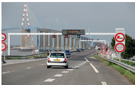
▲ La route communique dynamiquement avec l'usager via la signalisation : voie centrale en sens alterné sur le pont de St Nazaire-St Brévin
