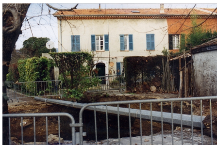
▲ Effondrement d'une route suite à des phénomènes de dissolution de gypse dans le sous-sol
