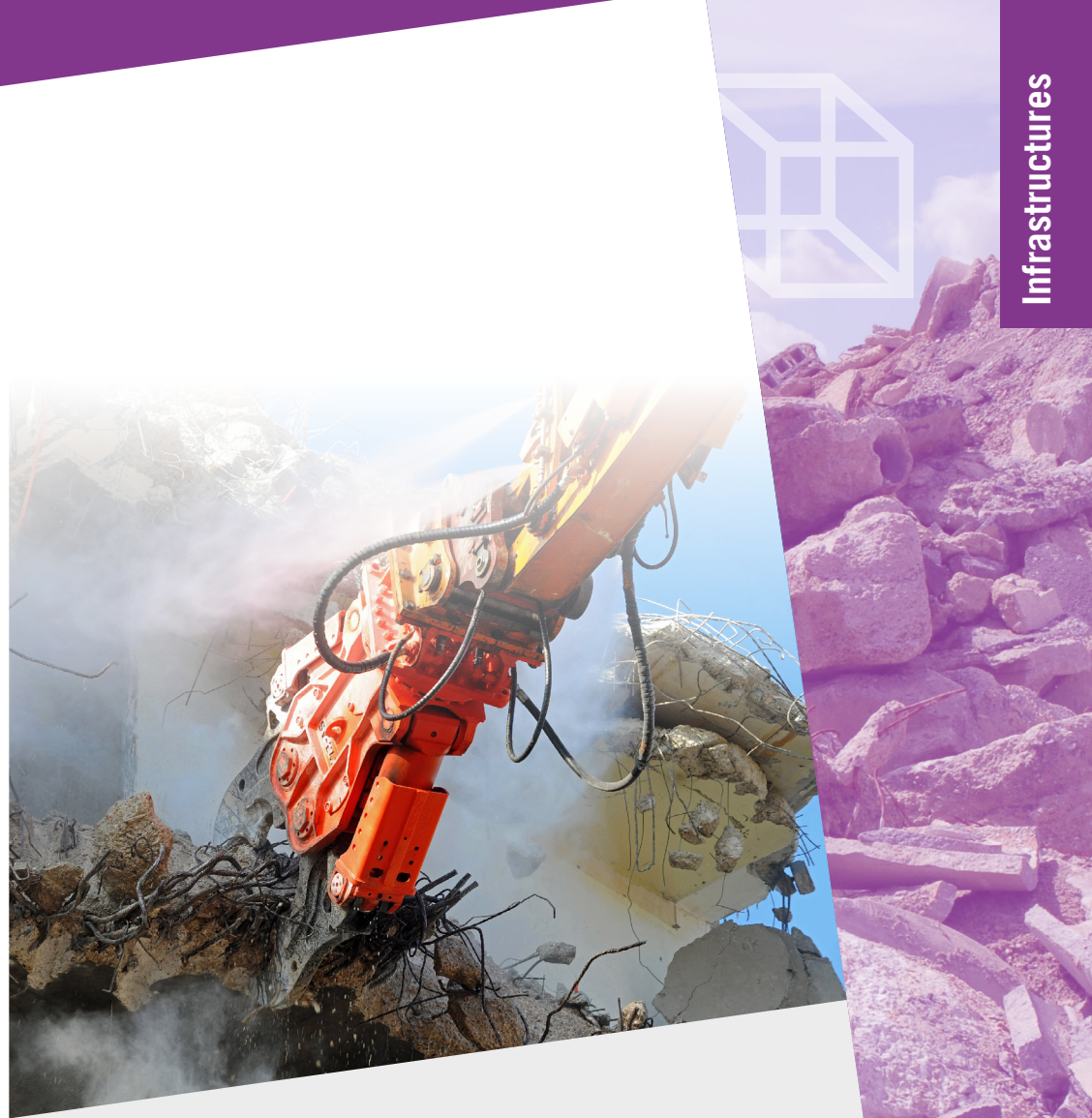
▲ Démolition à l'aide d'une tenaille
