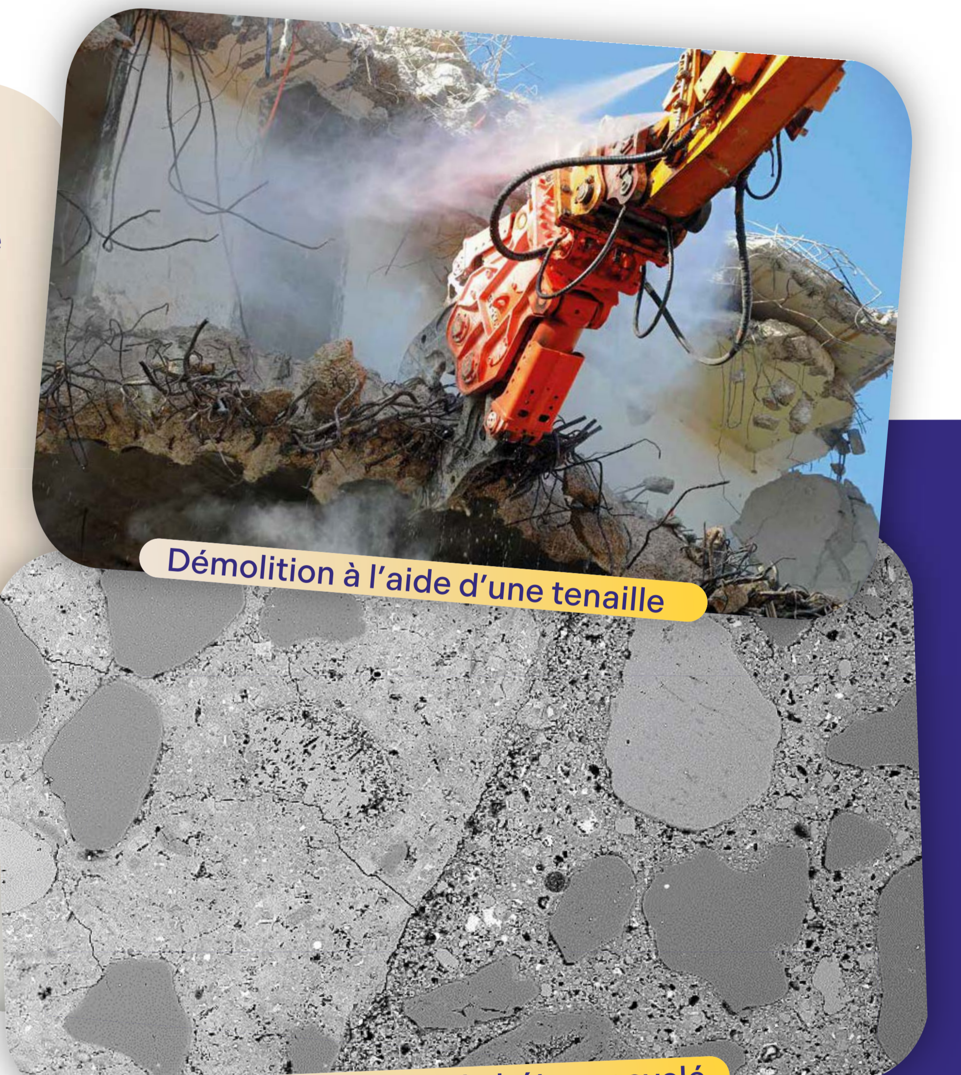
Microstructure du béton recyclé
